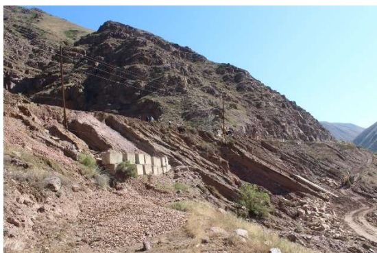
Рис. 10. Промоины на внешнем склоне железнодорожной насыпи, образованные после селевого потока 30.07. 2022 г.
