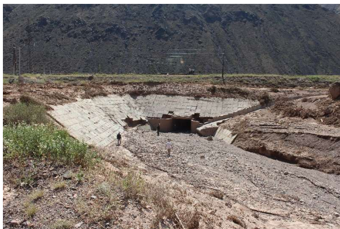
Рис. 9. Селесбросные туннели под полотном авто-и железной дороги.
