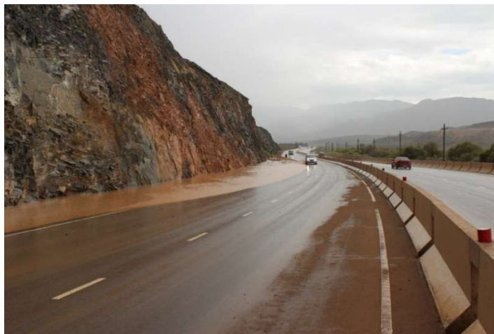
Рис. 11. Затопление дорожного полотна на 150,7-150,9 км дорожного полотна 18.07.2016 г.
