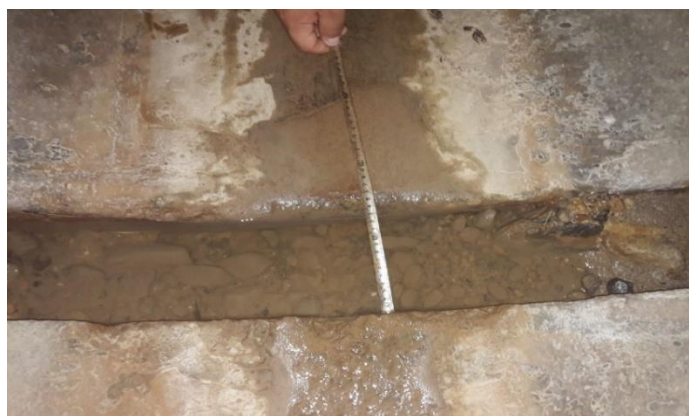
3-сүрөт. Жолдун үймө топурагынын суу түтүктөрүнүн бириккен жерлеринен аккан суудан нымдашуудан кийин деформацияланышы.
