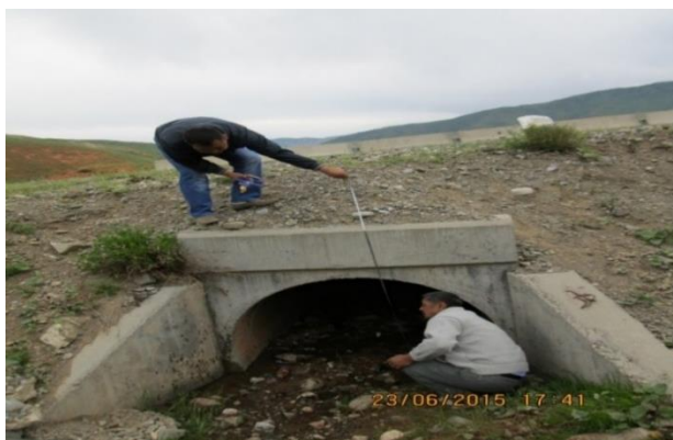
2-сүрөт. Суу өткөрүүчү түтүктөрдүн ичине суу агызып келген ылай басып калган.
