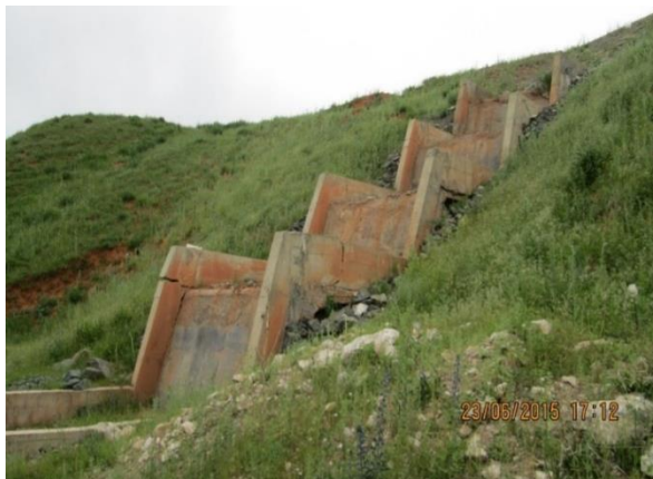
1-сүрөт. Жолдун жантаюсундагы суулардын ылдамдыгын азайтуучу текчелердин иштен чыгуусунан суу түтүктөрдүн астындагы жер кыртышынын деформациясы пайда болгон.
