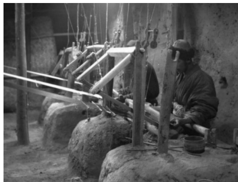
Рис. 2. Фото 1936 г. Станок для шёлкаткачества.
