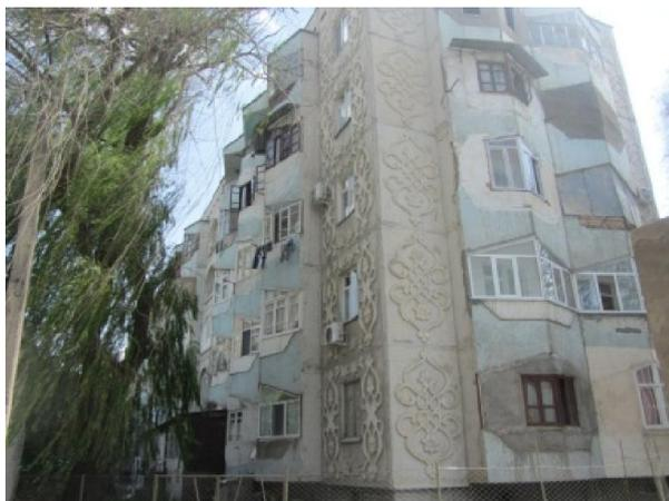
Рис. 4. Панельные здания (RC сборных структура стеновых панелей).
