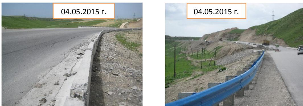
Рис. 3. Деформации откоса на 21-м км автомобильной дороги Ош-Исфана
