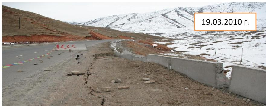
**Рис. 2.** Деформации откоса на 65-м км автомобильной дороги Ош-Сарыташ-Иркештам
