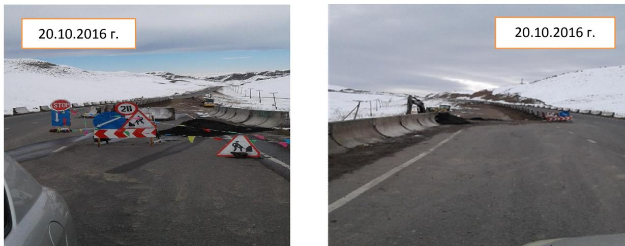
Рис. 4. Восстановительные работы разрушенного участка на 21-м км автомобильной дороги Ош-Исфана
