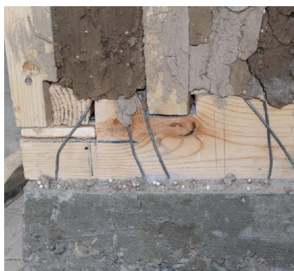
1-Сүрөт. «Сынч» түрүндөгү үйдүн моделинде көрсөтүлгөн байланыштар
