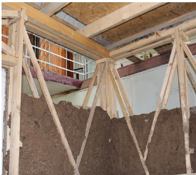
2-Сүрөт. «Сынч» түрүндөгү үйдүн моделинин өзөктөрүнүн ичин толтуруу
