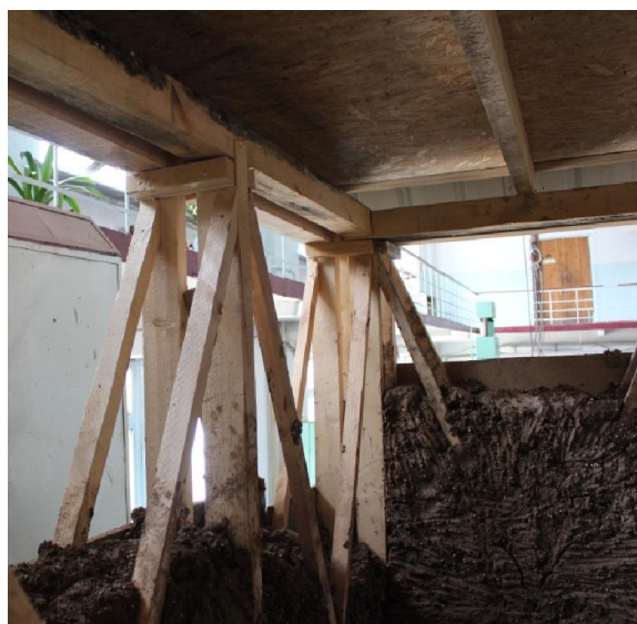
2-Сүрөт. «Сынч» түрүндөгү үйдүн моделинин өзөктөрүнүн ичин толтуруу
