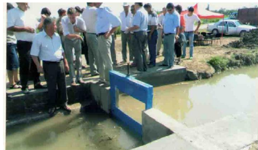
Рис.3 Водомер типа «Водослив-насадок» на Р-8 системы ЗБЧК. а – вид с нижнего бьефа (замер воды осуществляется водосливом); б – участники выездного семинара на сооружении (вид с верхнего бьефа) - обсуждается увиденное. (замер воды осуществляется водомером типа «Прямоугольный насадок»)
