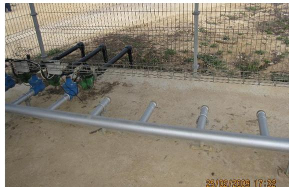
Рис. 2. Система управления для подпочвенного полива (Каталония, Испания) (фото Г. Донбаевой, 2009)
