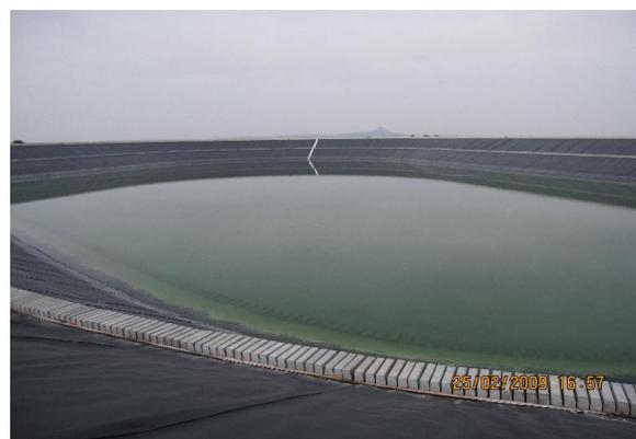
**Рис.7.** Наливное водохранилище для использования воды в подпочвенном орошении и последующим ее сбором обратно через КДС Каталония, Испания) (фото Г. Донбаевой, 2009)
