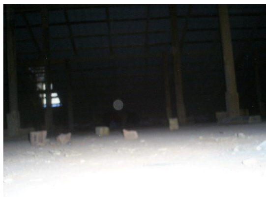
б) пункт наблюдения на чердаке
