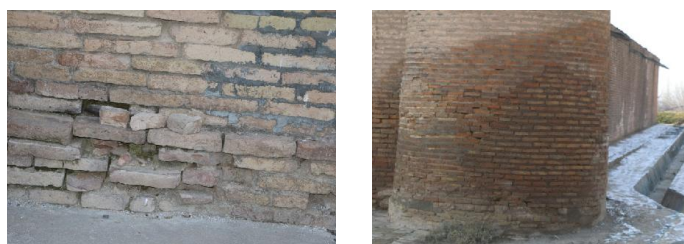
Рис 4. Повышенное выступление солей на всех основаниях фундаментов и стен
