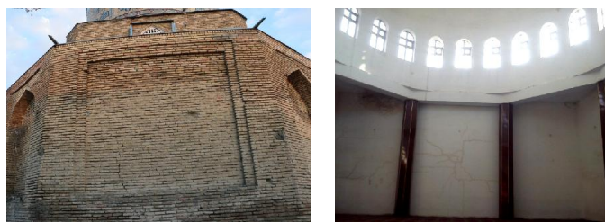
Рис. 2 Вертикальные и горизонтальные трещины в несущих конструкциях шириной до 2-5мм
