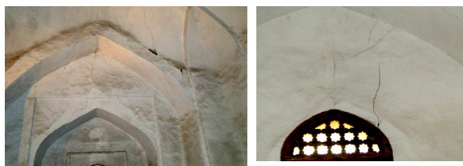
Рис 3. Оконтуривание волосяными трещинами кладки заложенных дверных и оконных проемов
