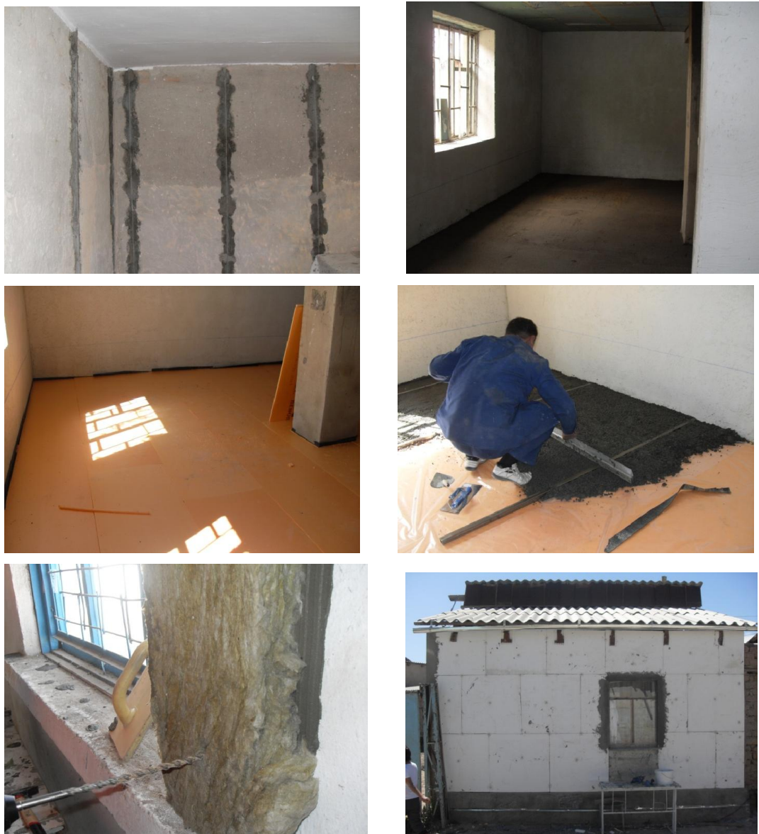
Рис. 1. Снимки, применяемых теплоизоляций и технологий по повышению энергоэффективности жилого дома.
