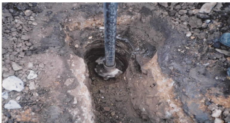
Рис. 3. Отбор проб земляного полотна по глубине дорожной одежды при бурении машиной УБГ 50М
